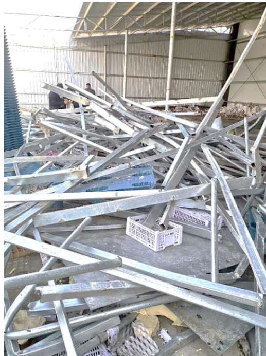
图 2 现场拆除的钢结构图片
