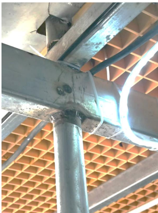
图 7 6 号保鲜库二层立柱直接焊接在次梁上图片
