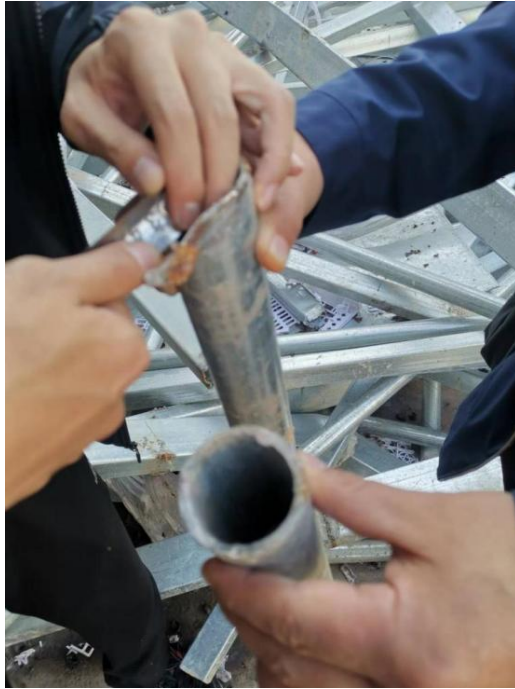
图 3 立柱壁厚现场检测图片
